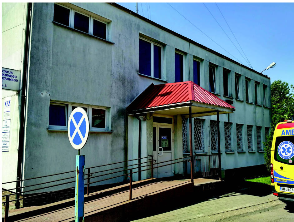
Rys nr 1. Elewacja północna budynku SP ZOZ WSPRiTS w Płocku przy ulicy Strzeleckiej 3.
